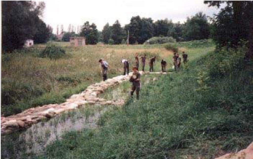
Abb.: Aufbau eines Sandsackschlosses auf der Binnenseite eines Deiches (Oderhochwasser 1997).
