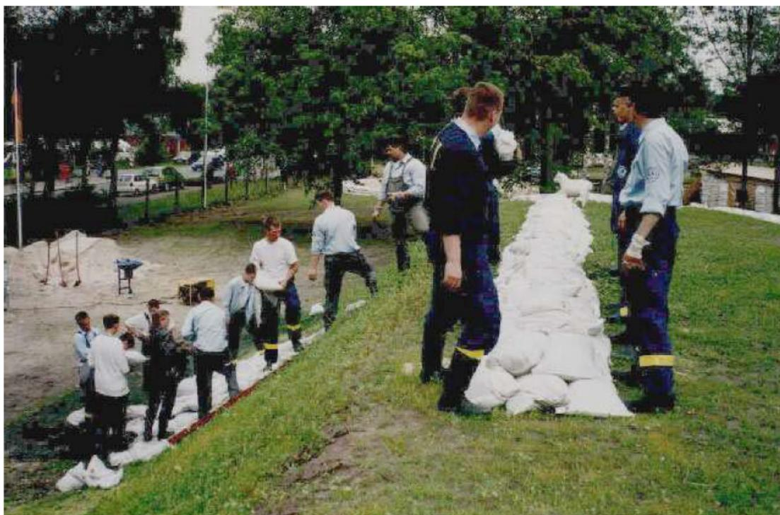
Abb.: Erhöhung eines Deiches mit Sandsäcken durch THW-Helfer während der Expo am Meer in Wilhelmshaven.
