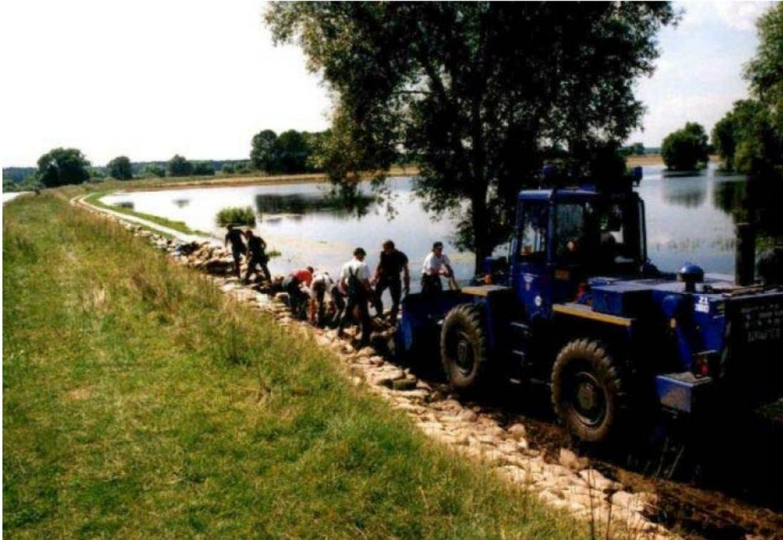
Abb.: Deichfußsicherung durch THW-Helfer 1997 beim Oderhochwasser.
